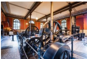
Wasserwerk am Hochablass (3)
